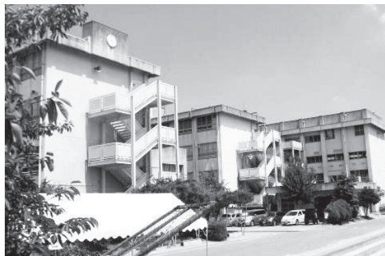
▲耐震補強工事が予定される第三中学校校舎
